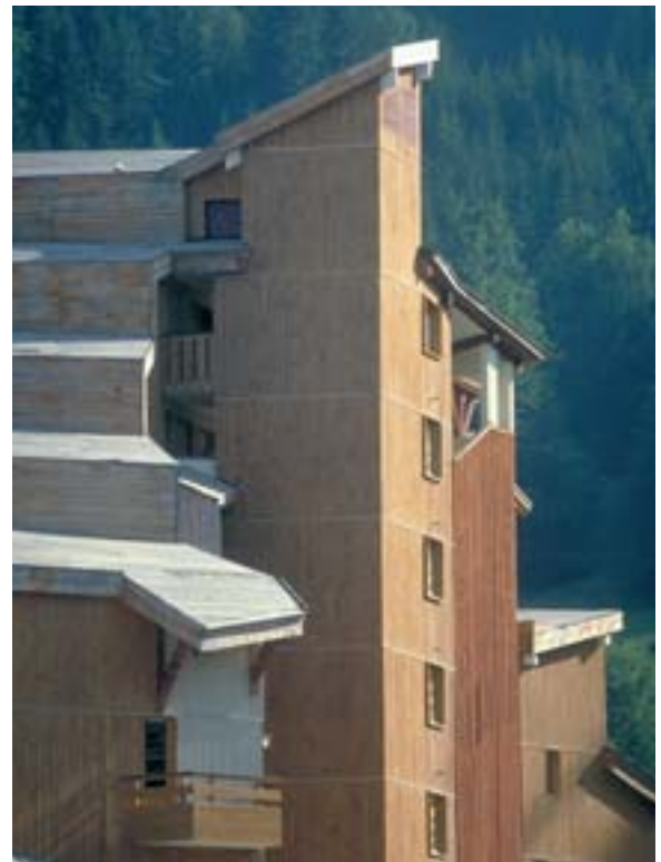
"Réglementation incendie IGH (Immeuble de Grande Hauteur)."
